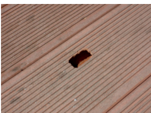
Beschädigte Hohlkammerdiele
